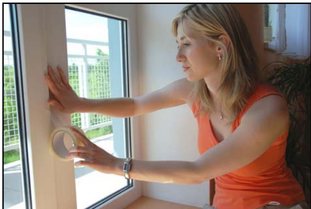
Obr. 2: Utěsnění oken lepící páskou.
